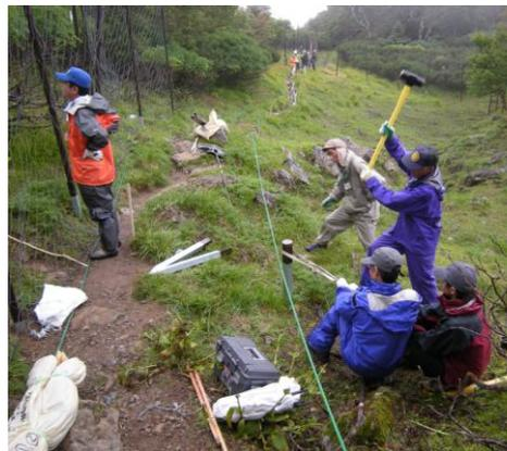
まず、長さ一メートルの鋼製角パイプ杭を殆ど地中に打ち込み、その中に地表二メートルの支柱を差し込む。杭と支柱の間には防水と振れ止めのためにプラスチックのくさびを打ち込む。それから支柱固定用の長さ七十五センチの鋼製角パイプ杭を斜めに打ち込み、クランプで固定する。この状態にワイヤー入りのロープを上下と中間に張り、やはりワイヤー入りの網を張る。網裾はプラスチックの止杭で固定して完成となる。鋼製とはいえ地中に岩や石があると杭が思うように真っ直ぐに入らない。ロープで引っ張ったり、金デコで押し下りして悔が残らないような仕事に努める。我々チームの宮下の杭打ち姿に「とても?高齢者とは思えない」との周囲の声、本人は「日頃の鍛錬の賜物だよ」と軽く
