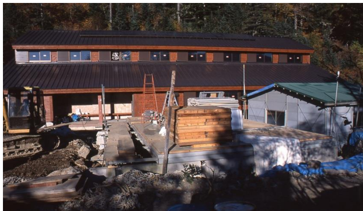
(建設中の白根御池小屋)
