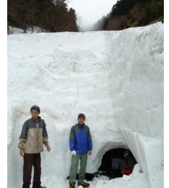
5月の中旬の白根御池。シーズンはじめ、一番大変なのは沢から水を引く作業。水源となる沢はまだ雪の下。毎年同じ場所で設置ができるよう大木を目印に勘だけで穴を掘る。雪の多い年は7m以上掘ることも。
