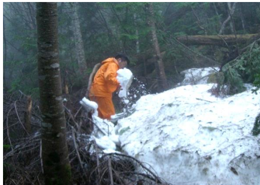
5月の中旬の白根御池。シーズンはじめ、一番大変なのは沢から水を引く作業。水源となる沢はまだ雪の下。毎年同じ場所で設置ができるよう大木を目印に勘だけで穴を掘る。雪の多い年は7m以上掘ることも。
