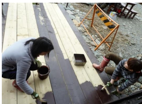
工事現場で使用する足場でテラスを作る。工業者が置いていった資材を有効活用して作成をはじめたが、毎年少しずつ大きくなり、現在では、すっかり御池小屋の建物の一部となった。
